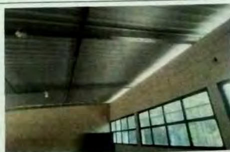
Foto 17: MODULO B Interior de aula Sustitucion de cubierta de asbesto en mal estado y se coloco estructura de metal a base de costaneras de metal.
