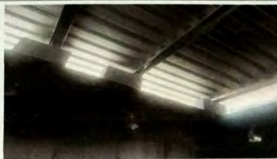
Foto 8: MODULO COCINA Cambio de estructura de metal en mal estado por estructura de metal a base de costaneras. Cambio de lamina de zinc por lamina troquelada cal 26.
