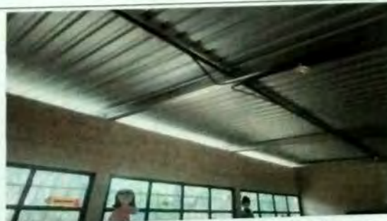
Foto 16: MODULO B AULA interior de aula Sustitucion de cubierta de asbesto en mal estado y se coloco estructura de metal a base de costaneras de metal.
