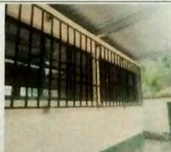
Foto 12: MODULO A Balcones en vanos de aulas y vista corredor donde se cambio cubierta de asbesto por lamina troquelada cal 26.
