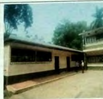
Foto 14: MODULO B AULA Sustitucion de cubierta de asbesto en mal estado y se coloco estructura de metal a base de costaneras de metal. Se instalaron balcones en ventaneria para seguridad.
