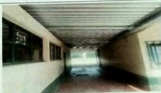
Foto 15: MODULO B CORREDOR Sustitucion de cubierta de asbesto en mal estado y se coloco estructura de metal a base de costaneras de metal.
