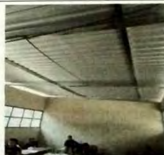
Foto 10: MODULO A AULA. Sustinucion de cubierta de asbesto en mal estado y se coloco estructura de metal a base de costaneras de metal.
