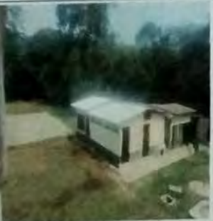
Foto 5: MODULO DE SERVICIOS SANITARIOS Y COCINA. Cambio de estructura de metal en mal estado por estructura de metal a base de costaneras. Cambio de lamina de zinc por lamina troquelada cal 26.
