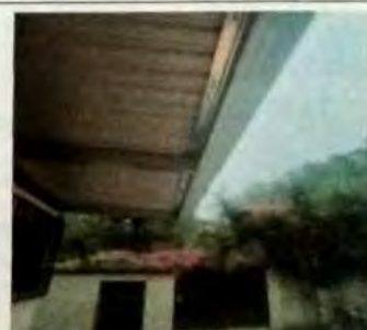
Foto 12: MODULO A Balcones en vanos de aulas y vista corredor donde se cambio cubierta de asbesto por lamina troquelada cal 26.
