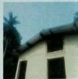
Foto 2: VISTA MODULO D SERVICIOS SANITARIOS. Cambio de estructura de metal en mal estado por estructura de metal a base de costaneras. Cambio de lamina de zinc por lamina troquelada cal 26.
