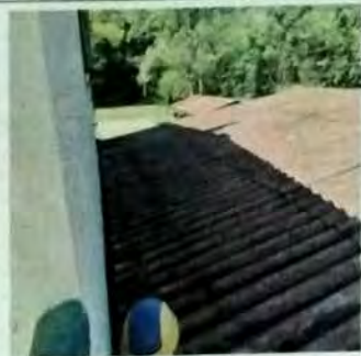
Foto 13: MODULO B AULA Sustitucion de cubierta de asbesto en mal estado y se coloco estructura de metal a base de costaneras de metal.
