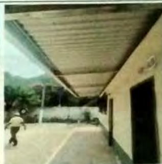
Foto 14: MODULO B AULA Sustitucion de cubierta de asbesto en mal estado y se coloco estructura de metal a base de costaneras de metal. Se instalaron balcones en ventaneria para seguridad.
