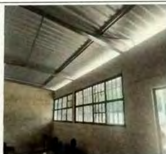
Foto 10: MODULO A AULA. Sustinucion de cubierta de asbesto en mal estado y se coloco estructura de metal a base de costaneras de metal.
