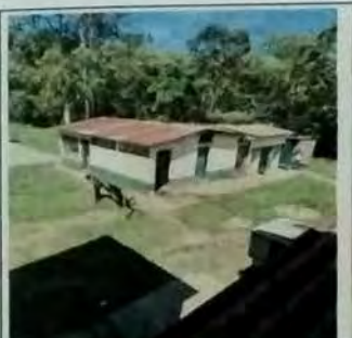
Foto 5: MODULO DE SERVICIOS SANITARIOS Y COCINA. Cambio de estructura de metal en mal estado por estructura de metal a base de costaneras. Cambio de lamina de zinc por lamina troquelada cal 26.
