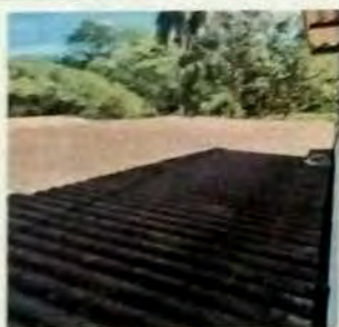
Foto 9: MODULO A AULA Sustinucion de cubierta de asbesto en mal estado y se coloco estructura de metal a base de costaneras de metal.
