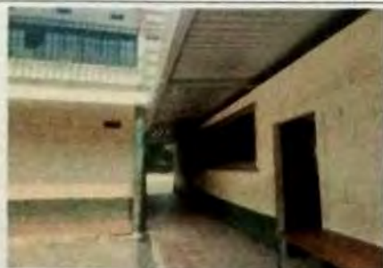
Foto 11: MODULO A Corredor Sustinucion de cubierta de asbesto en mal estado y se coloco estructura de metal a base de costaneras de metal.
